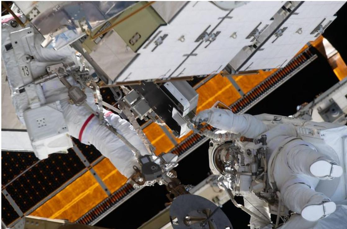
図 4-19 P6 トラスでのバッテリー交換作業 ©NASA
