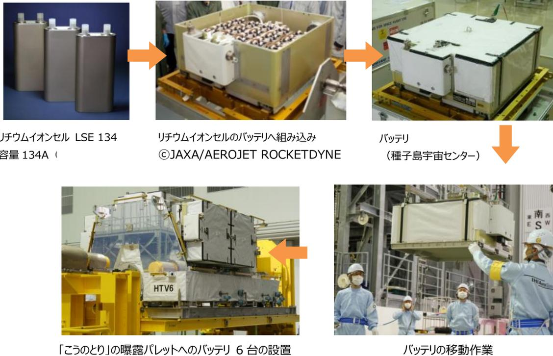
図 4-17 バッテリー搭載までの流れ ©JAXA
