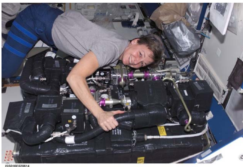
図 5.1.1-1 修理のために CDRA を空気再生ラックから引き出した状態 (下側の箱状の部分が CDRA ベッド、以下の写真を参照)
